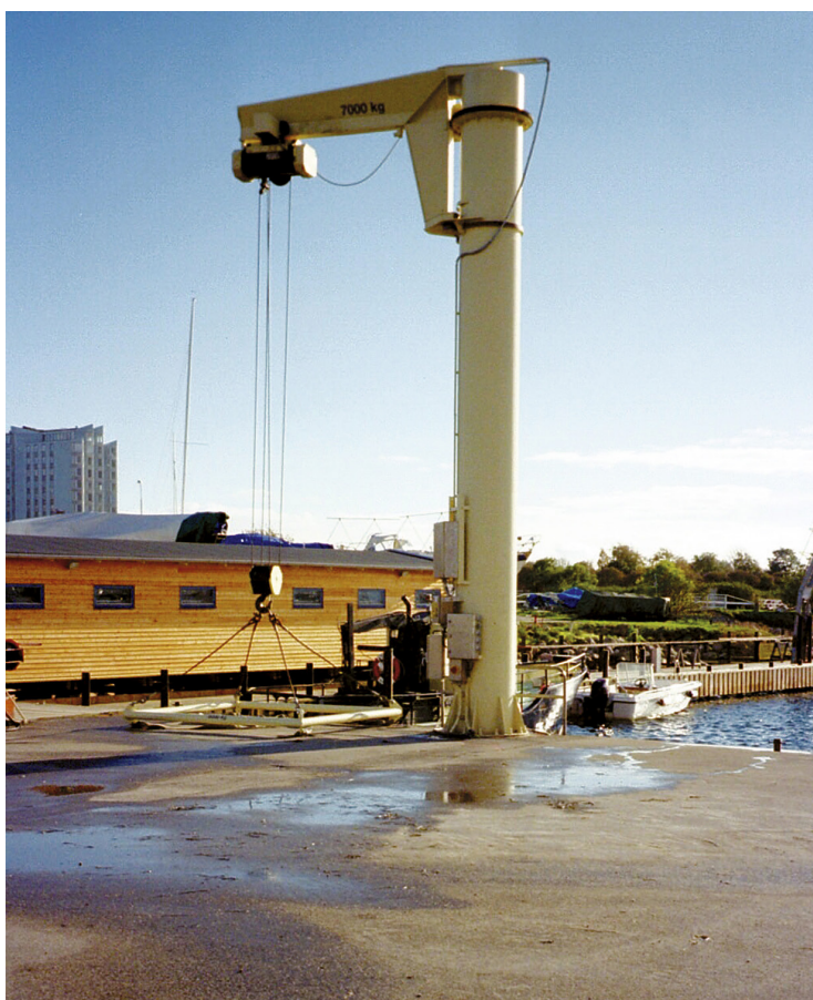
Bild 3:1 Fast svängbar kran. Observera det breda lyftoket. Se fig 3:5.
