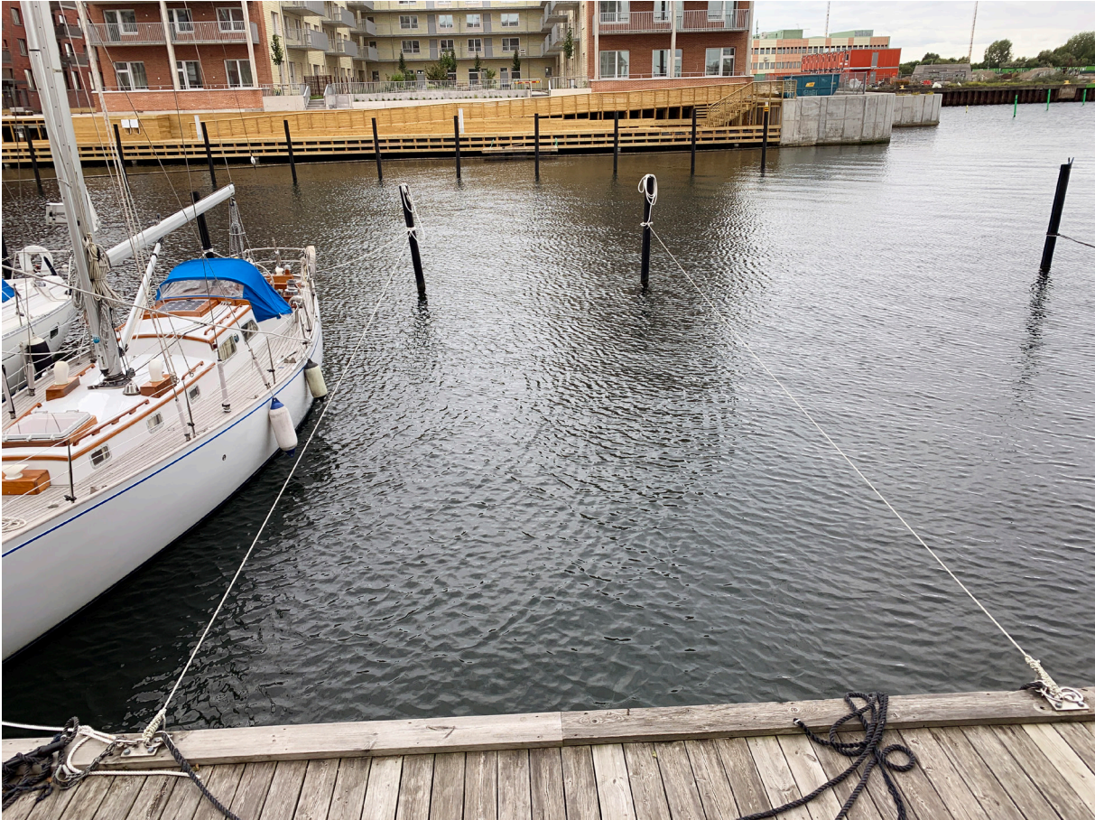
Bild 2:50 Här ett exempel på förtöjning där löpliner från stolpar till bryggan som används för att hålla båten på rätt kurs fram till bryggkanten. Foto: Jimmy Dominus.
