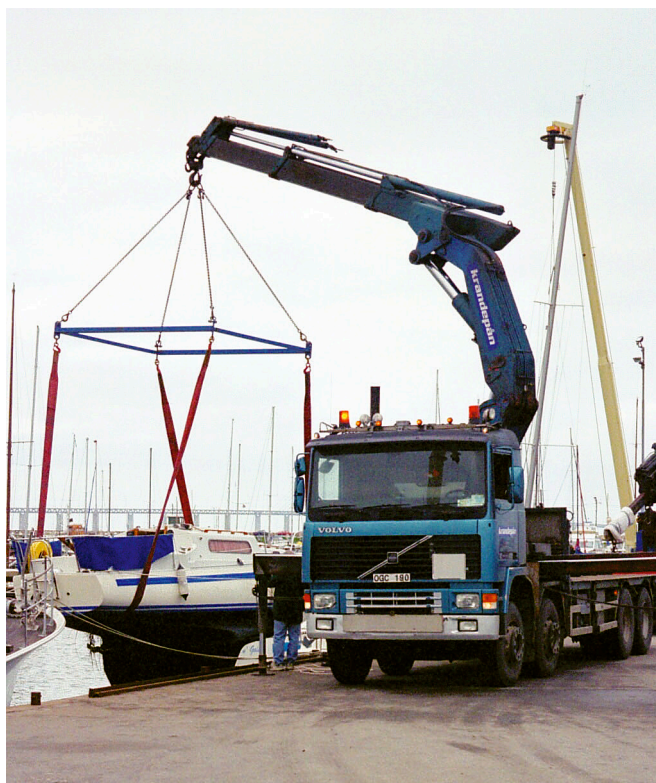
Bild 3:4 Lastbil med kraftig kran och lyftok. Även här gäller att ha stödbenen utfällda och att säkra slingan.
