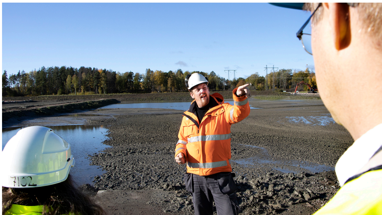
Johan Björk, platschef PEAB anläggning på Grindsängens verksamhetsområde i Västerås, informerar representanter för Sjöfartsverket, Västerås stad och Köpings kommun, om arbetet med muddermassorna.
